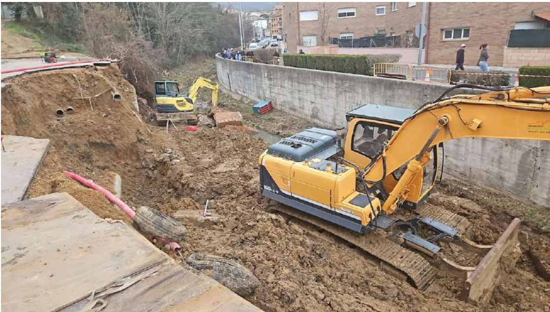
Trabajos con maquinaria este lunes en la riera de Sant Amanç, en Anglès (La Selva).
