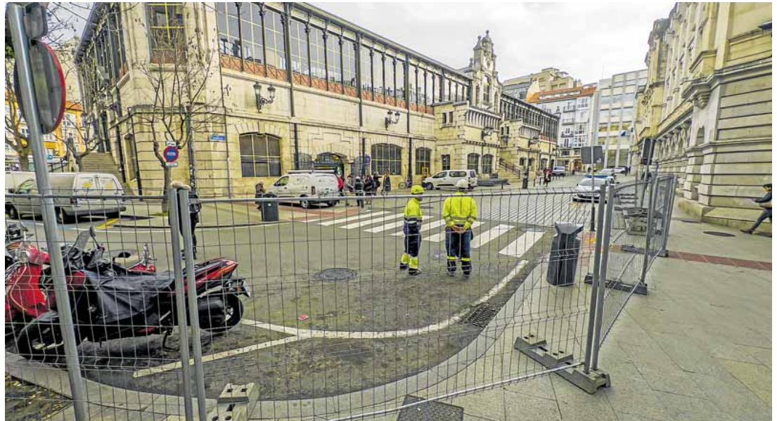
Varios operarios, ayer, junto a las vallas colocadas en la calle Los Escalantes, en la confluencia con la calle El Mercado, por el inicio de las obras para evitar inundaciones en el entorno de la plaza del Ayuntamiento de Santander, una de las zonas más afectadas de la ciudad. DANIEL PEDRIZA
