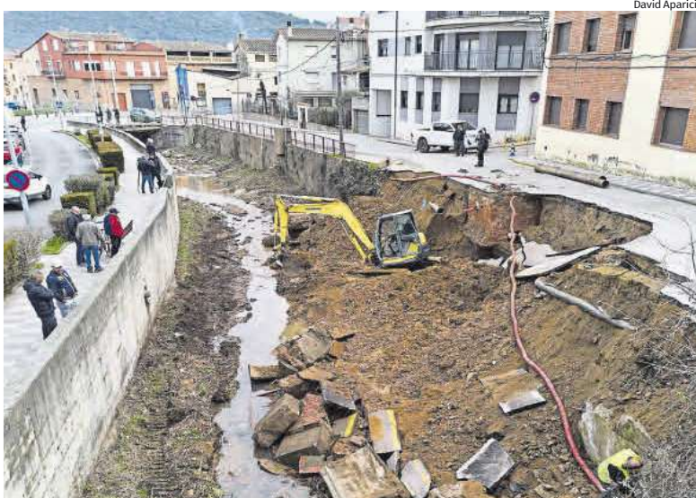
Una màquina treballa en la reparació de la canonada d'aigua afectada.
